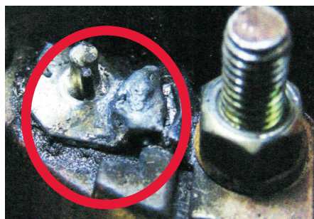
Buena junta de soldadura
